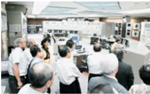
発電所中央制御室
